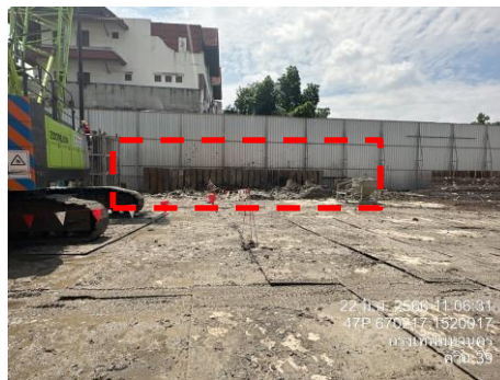
รูปที่ 39 Sheet Pile
